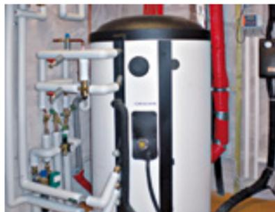
Solarspeicher mit Verrohrung und Regeltechnik
