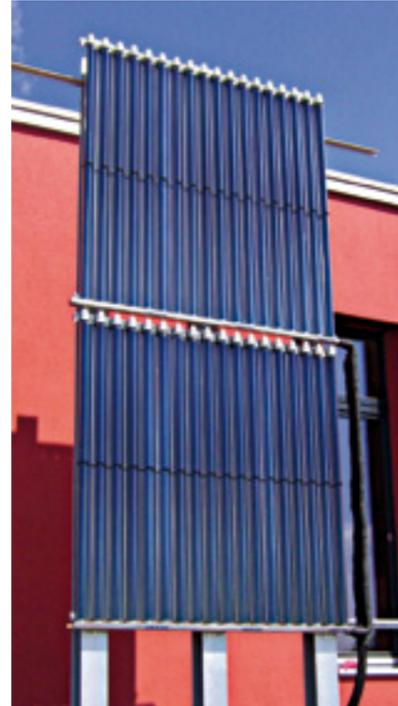
Regenerative Energiegewinnung (Vakuumröhrenanlage für die Heizungs-/ Warmwasserunterstützung)
